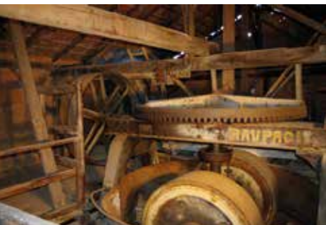
Maschinenhaus mit Kollergang, Foto: Nordostkultur
